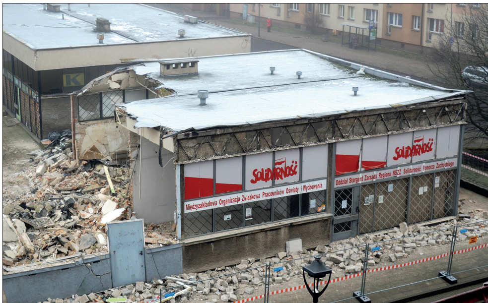
Ryc. 1. Wyburzenie pawilonów handlowych przy ulicach: Kazimierza Wielkiego i Kramarskiej, wg stanu z 18 lutego 2018 r. Fot. A. Bierca, MAH w Stargardzie
